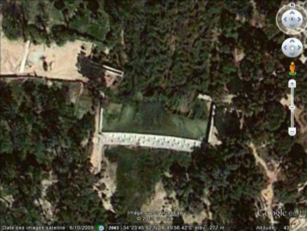
L'ouvrage de déviation à LELA
