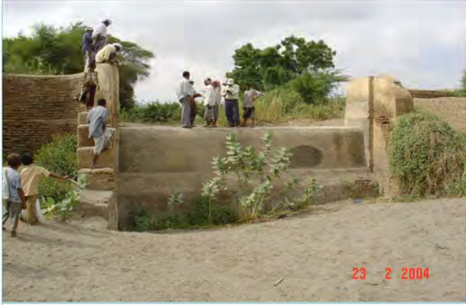
تصویر نمبر 1: ناہموار زمیں اور پانی کی طاقت توڑنے کے لئے بنایا گیا ڈانچہ جس کی تعمیر (steps) میں کمی گئی ہے۔
