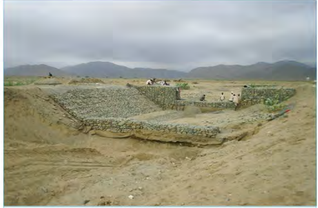
تصویر نمبر 2: چینل کی سطح کو برقرار رکھنے کے لئے پانی تقسیم کرنے کا ڈانچہ جس میں (Apron) کی لمبائی مناسب حد تک ہے۔
