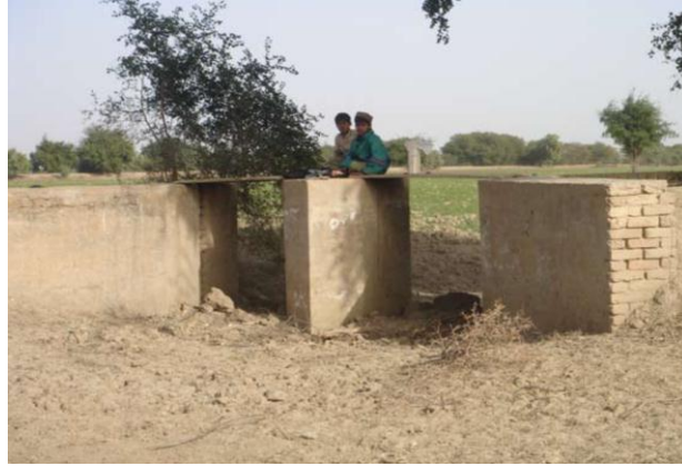
الشكل رقم (٩) بوابة مدخل الحقل بسدادة
