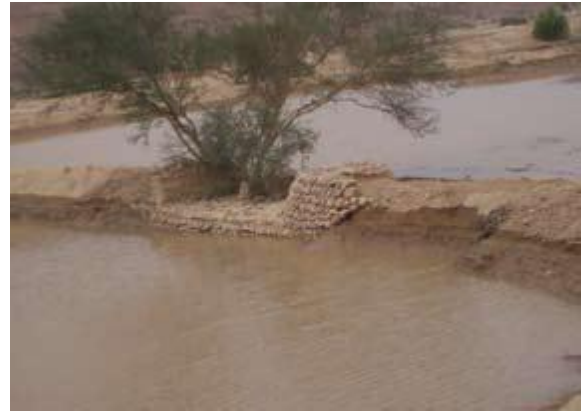
الشكل رقم (٦) منشآت مفيض مقواه (مبطن) بالأحجار
