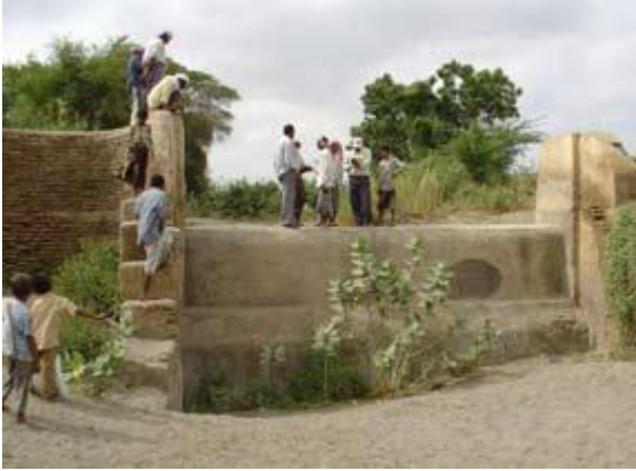
الشكل رقم (١) منشآت المسقط المائي لتغلب على فروق مستوي المناسيب وتبديد الطاقة في وادي زيبيد اليمن، لاحتظ تنفيذ الدرج
