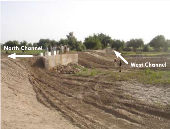
ስዕል 4. ሞኖትሃ ፍራውት ማከፋፈያ ስትራቴጂ (Flow Division Structure)
