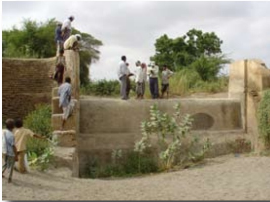
ስዕል 1: አውራጃ ስትራክቸር (Drop Structure)
