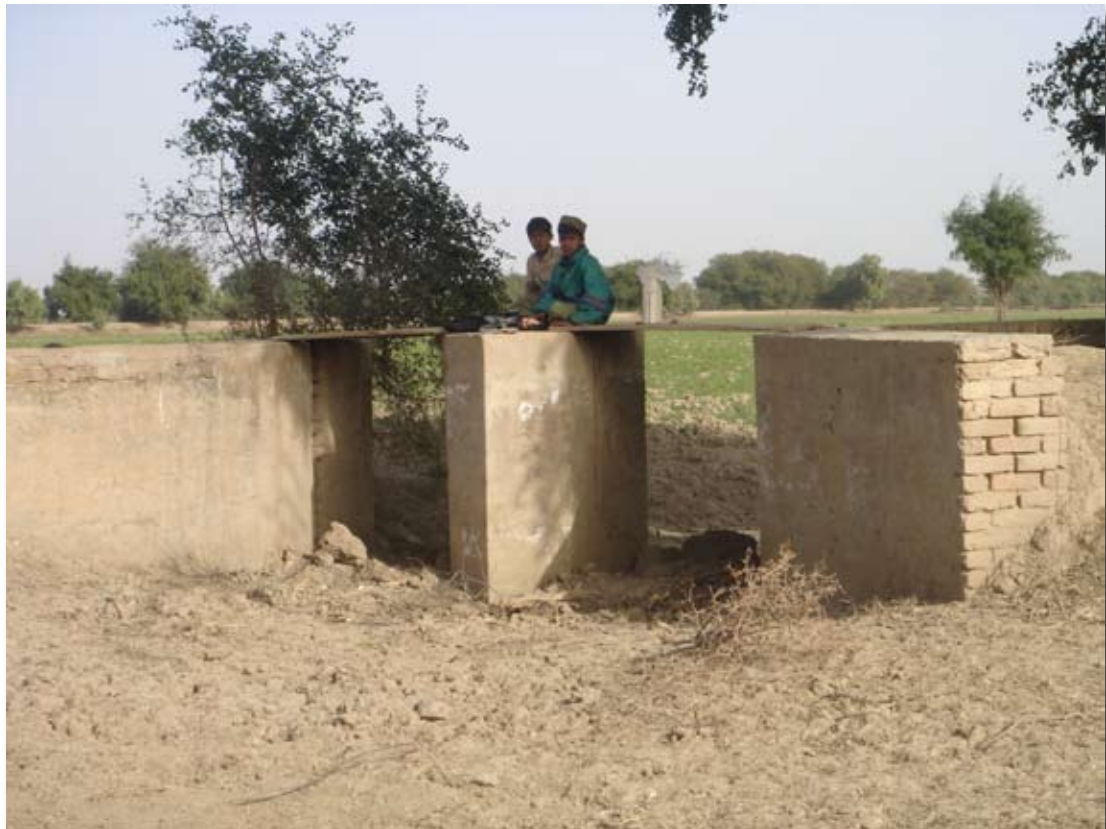
ስዕል 9: የውሃ መግቢያ በር እና የግንድ መዝገያው (Intake gate with Stop-Logs)
