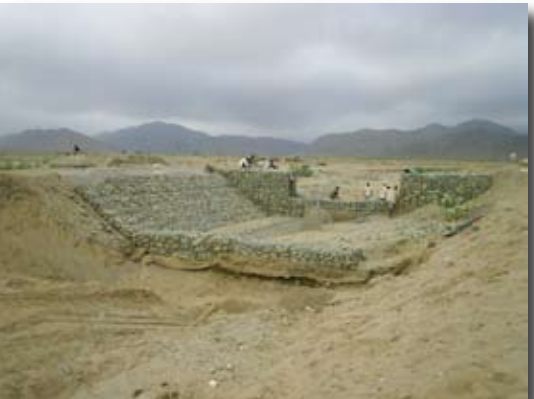
ስዕል 2: ፍሰትን አከፋፋይ (Flow Divider) እና የሰይ ወለልን ማረጋገጫ (Channel bed stabilizer)
