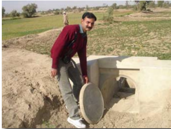
ስዕል 8: የተሻሻሉ ከማሳ ወደ ማሳ ማሳለፊያ (Improved Field over Flow Structure)
