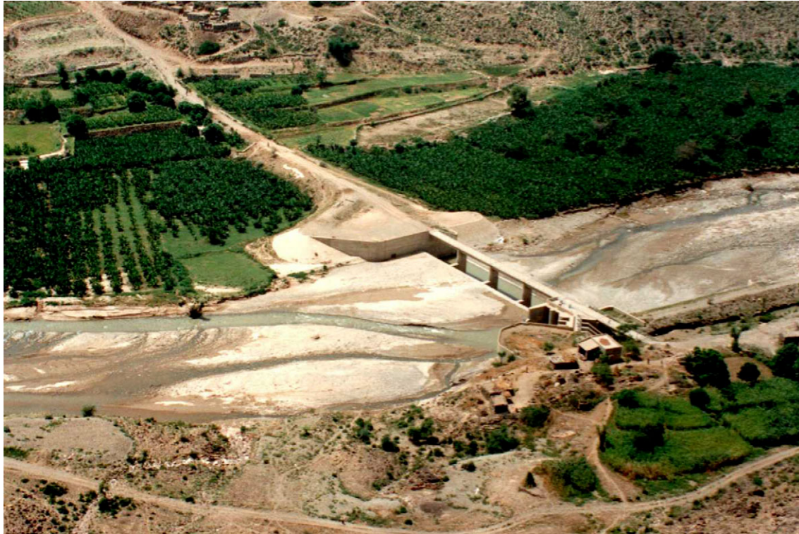
Figure 10.13 Wadi Rima spate irrigation intake, Yemen
